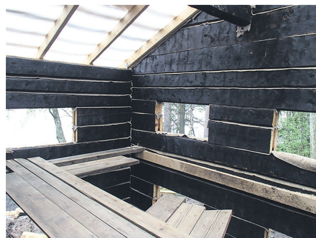
Riihisaunan hirret on saatu mustiksi polttamalla. Saunominen tapahtuu toisessa kerroksessa ja peseytyminen alakerrassa.
